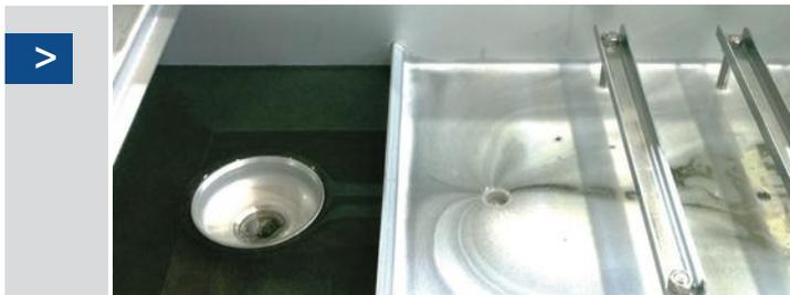
Die RTG Hydraulikeinheit saugt aufschwimmende Öle und Partikel im DPS 120 Koaleszenz-Ölabscheider ab.
